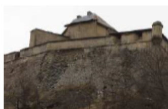
Parement déstructuré sur rempart ouest (caractère d'urgence)
