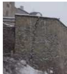
Fissure importante dans le rempart de l'enceinte d'entrée, se poursuivant sur l'autre face de l'angle (caractère d'urgence)
